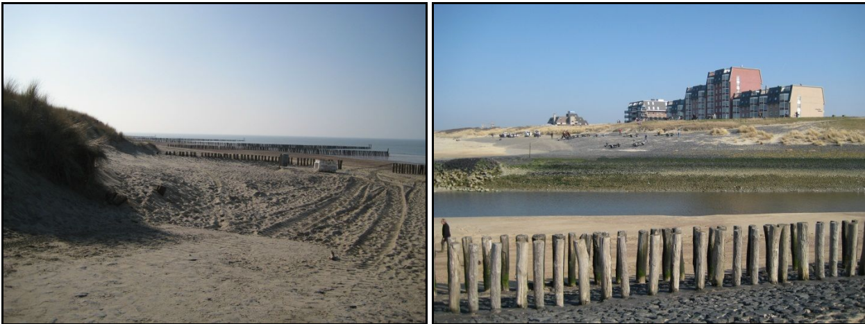
Figuur 5.2 Glooiing ten westen van het gemaal (links) en glooiing ten oosten van het gemaal (rechts)
