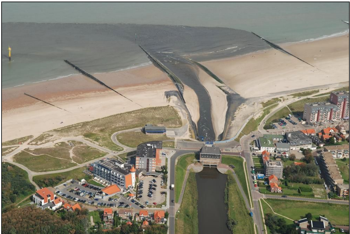
Figuur 5.6 Uitwatering onder vrij verval (Vertroebeling is een indicatie voor verhoogde stroomsnelheden gepaard gaande met erosie) [Svašek Hydraulics, 2012]
