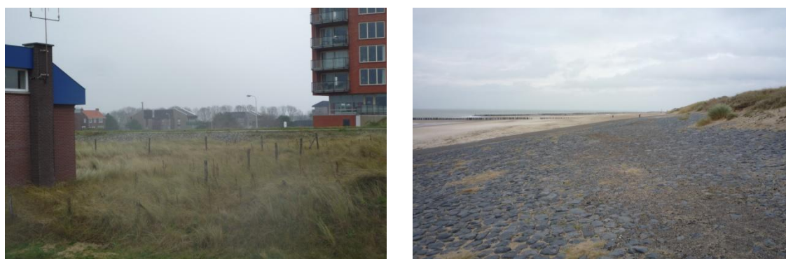
Figuur 2.2: Glooiing ten westen van het gemaal (links) en glooiing ten oosten van het gemaal (rechts).
