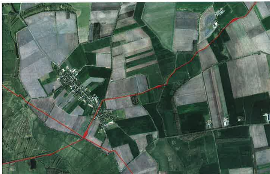
Figuur 11i: Buisleiding in het zuidwesten van Coevorden PR10E-06
