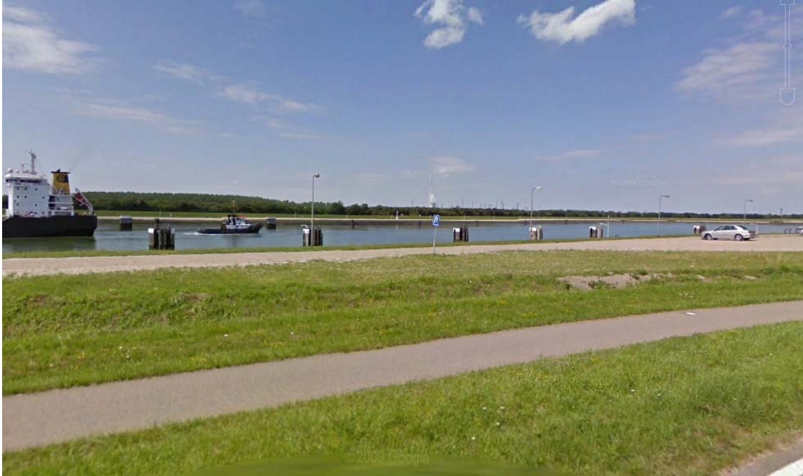
Figuur 12.10 Uitzicht vanuit de kern Terneuzen op het plangebied MVP, locatie A (Bron: streetview, Google Earth)
