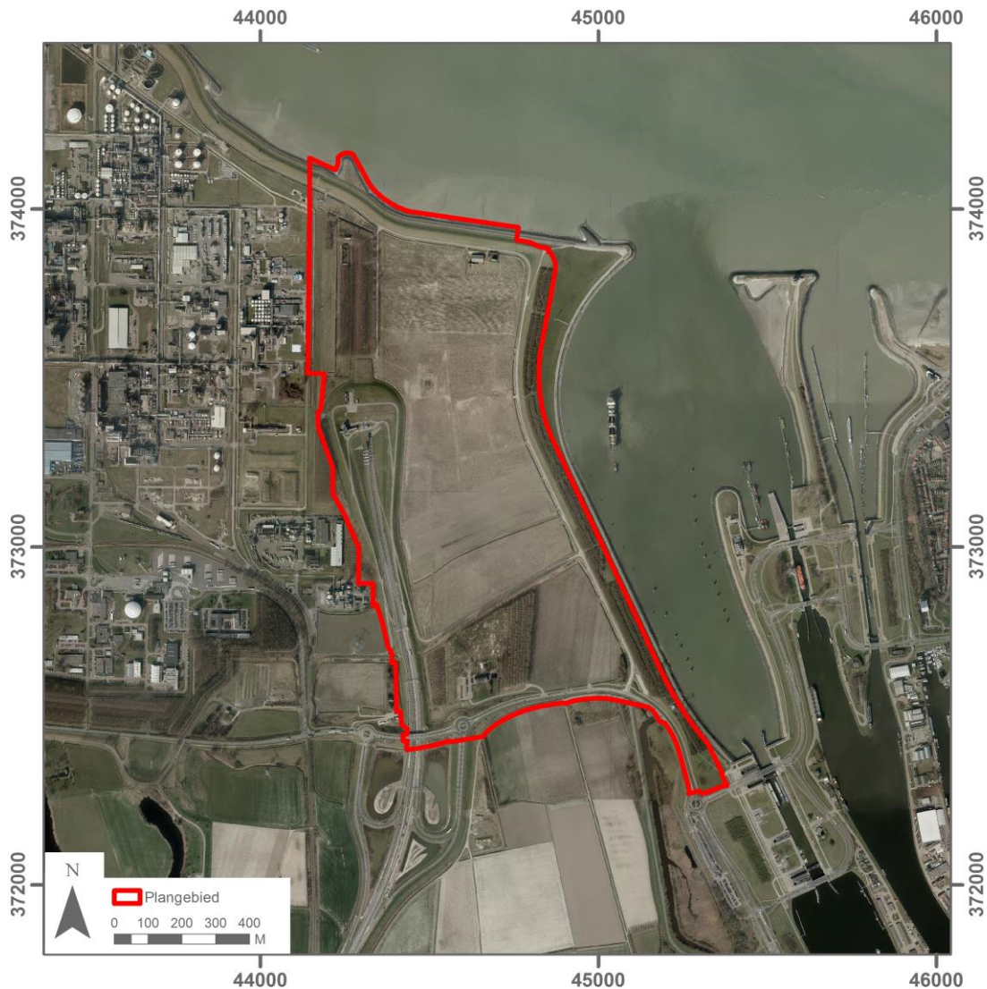
Figuur 5. Ligging van het BP Maintenance Valuepark op een luchtfoto uit 2012. Op deze foto is goed zichtbaar dat de bodem van het middenstuk geroerd is geweest. Deze zone is in gebruik geweest als laydownarea en bouwterrein van de Westerscheldetunnel. Dit heeft mogelijk effect gehad op de bodem als een verstoring van het bodemarchief (Bron: www.zeeland.nl/chs ).
