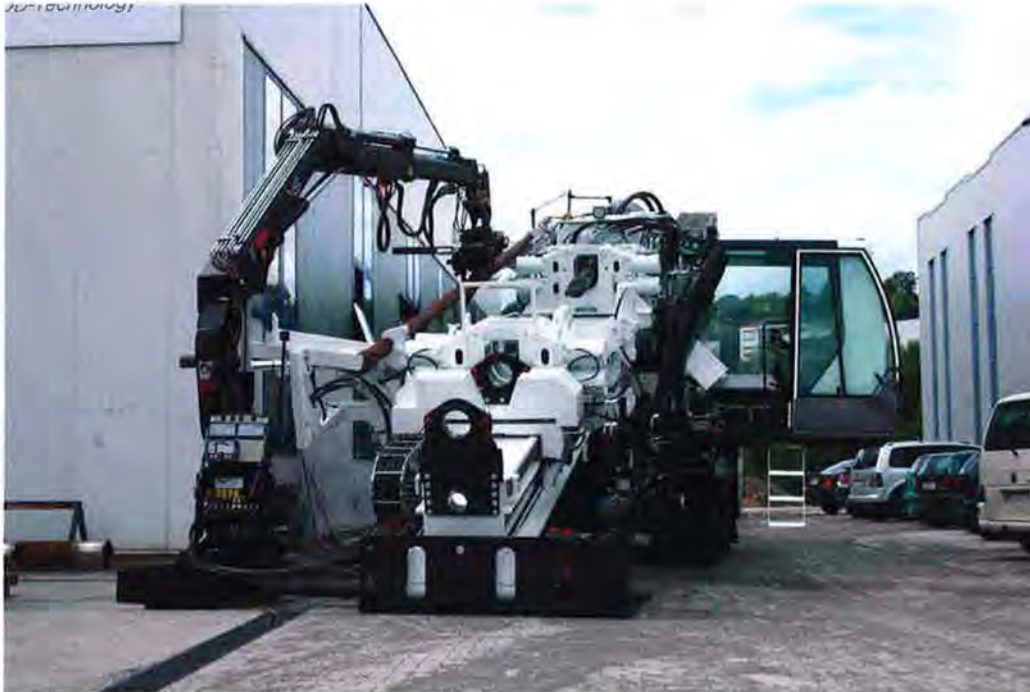
Afbeelding: 250 tons boor-rig Van Vulpen
