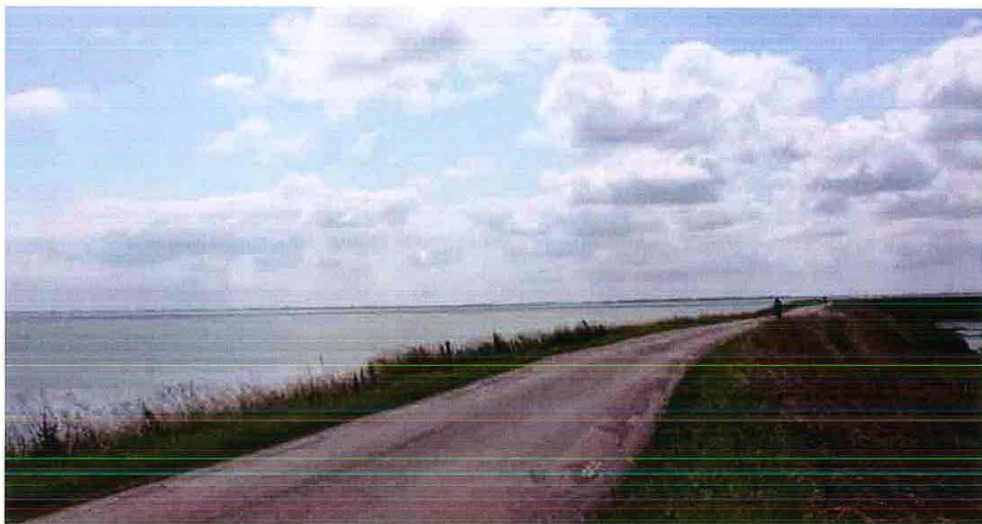
De Westfriese Omringdijk en het Markermeer
