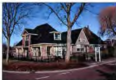
Nieuwbouw gebaseerd op traditionele gebiedseigen bouwvorm.
