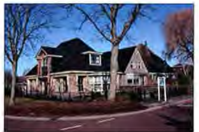
Nieuwbouw gebaseerd op traditionele gebiedseigen bouwvorm.
