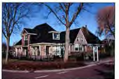
Nieuwbouw gebaseerd op traditionele gebiedseigen bouwvorm.
