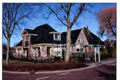
Nieuwbouw gebaseerd op traditionele gebiedseigen bouwvorm.
