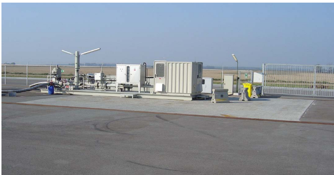
Figuur 3 Voorbeeld van een locatie met een KISS-skid, zoals op de locatie Roswinkel-1 geplaatst zal worden voor de winning van het aardgas.
