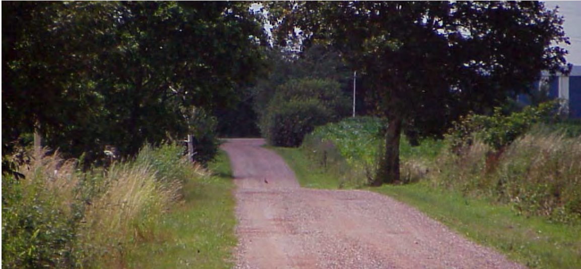
Figuur 3-3: Verzakking aan het maaiveld aan de Boekeloseveldweg.
