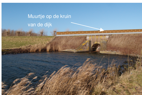
Figuur 8-2 Gemaal Westerse Polder, aanzicht van de uitstroomzijde (zijde Haringvliet) met gepland muurtje op de kruin
