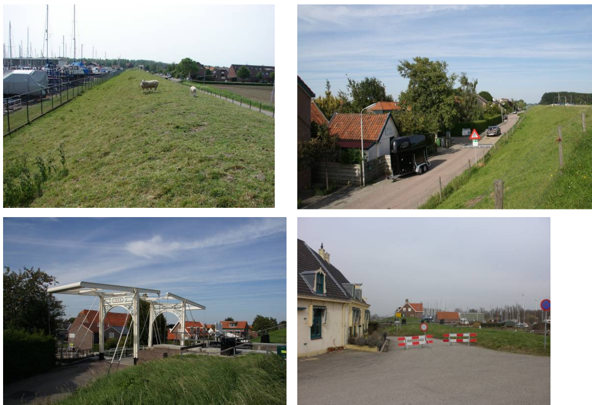
Figuur 5-1 Strijensas Sassedijk (onbebouwd (km 27,51), bebouwd (km 27,9), sluis en brug, op de hoek (km 28,0))
