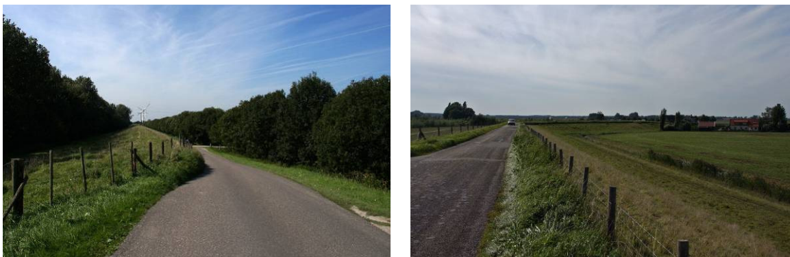
Figuur 3-2 Bomen langs dijk op het traject Hoge Westerse Zomerpolderse kade en de onbeplante dijk op het traject Buitendijk Strijensas
