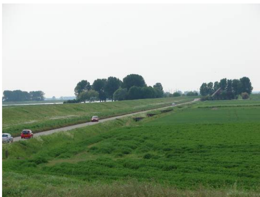
Figuur 5-7 Buitendijk Zuid-Beijerland (buitenzijde en binnenzijde met weg, km 44,8)
