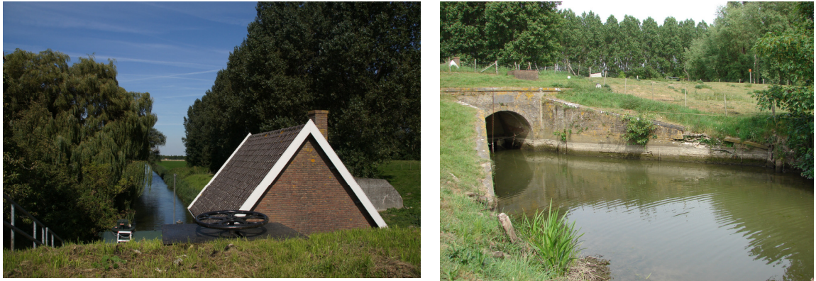
Figuur 8-1 Gemaal Hoogezandse Polder, huidige situatie; links instroomzijde, rechts uitstroomzijde
