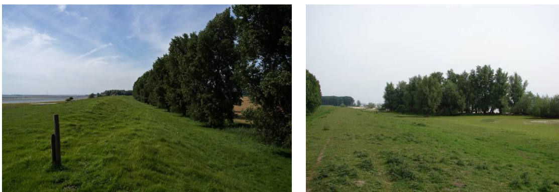
Figuur 5-5 Hoogezandse Buitendijk West (km 35,2 en 36,0)
