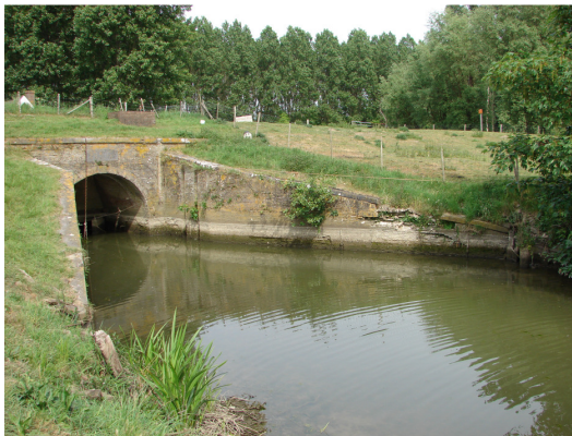
Gemaal Hoogezandse Polder
