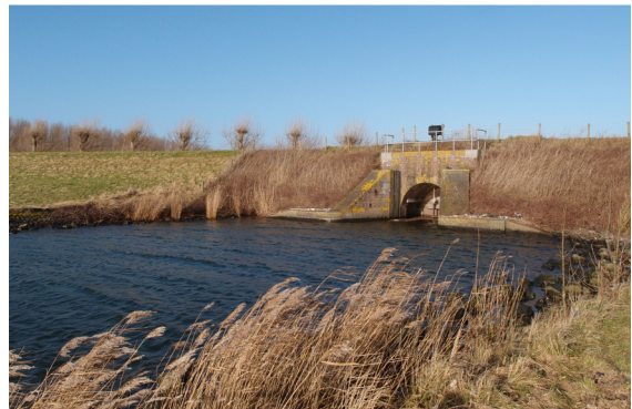
Gemaal Westerse Polder
