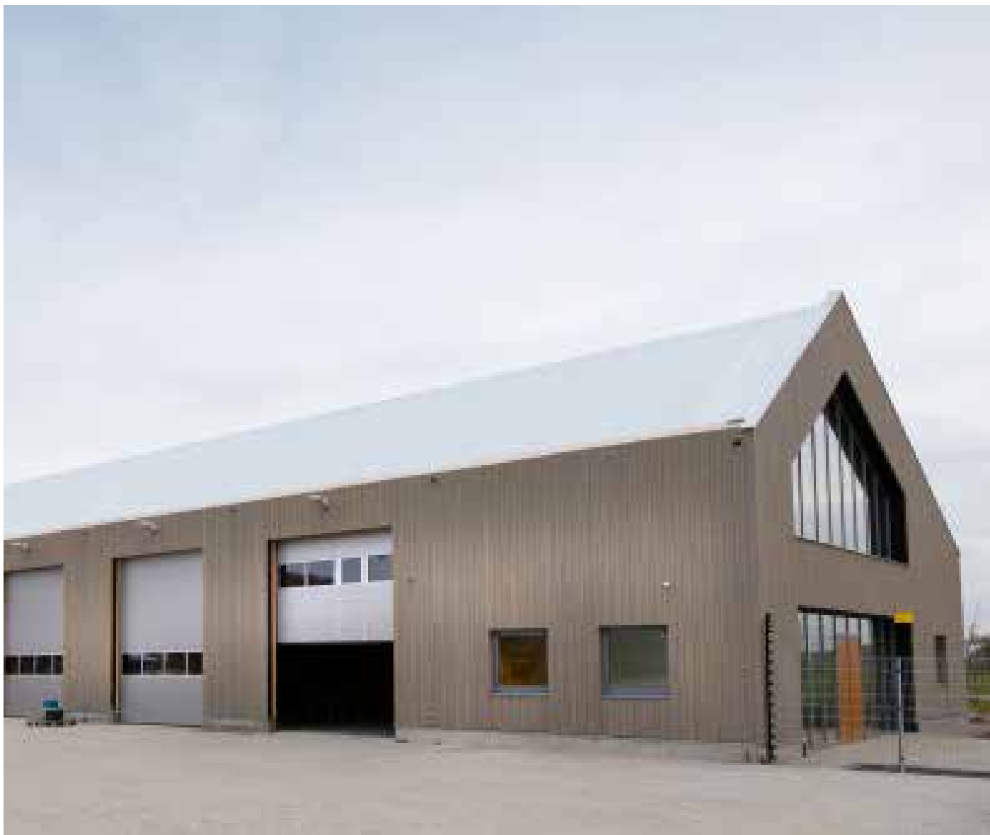
Kantoor als integraal onderdeel van de bedrijfshal
