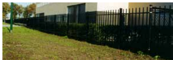
Erfgrens middels een hekwerk met verticale spijlen
