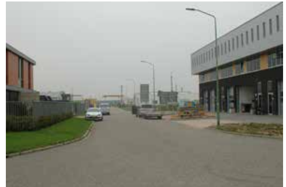
Bestaande bedrijventerrein Bruine Kilhaven
