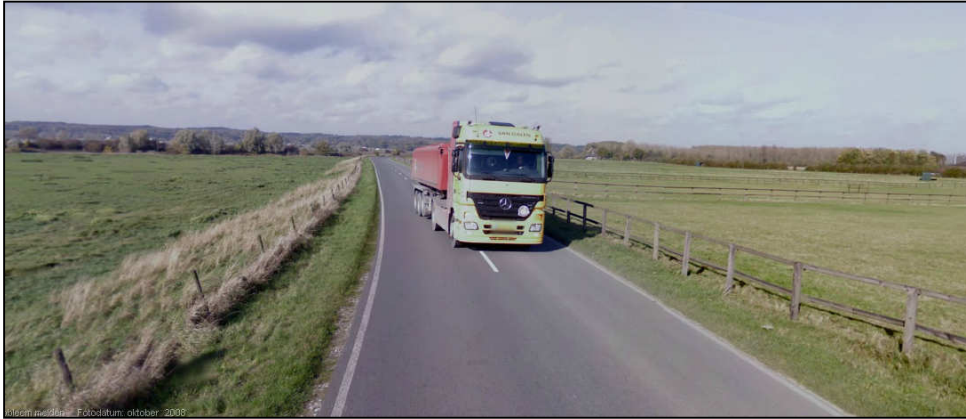
Figuur 5.38 Aanzicht van wegbreedte en -profiel van de weg Havikerwaard
