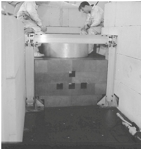
Figuur 5 Plaatsen van de uitwendige grafietreflector rondom de kern, 1959, gezien vanaf de thermische kolom (huidige westzijde)
