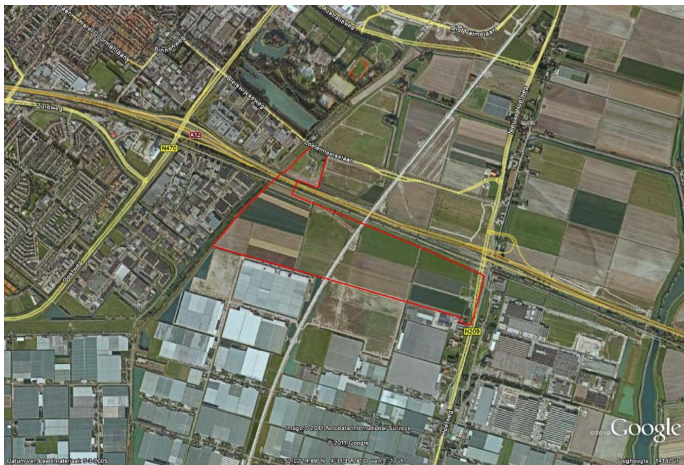
Fig. 9. Luchtfoto (overzicht) van het plangebied
