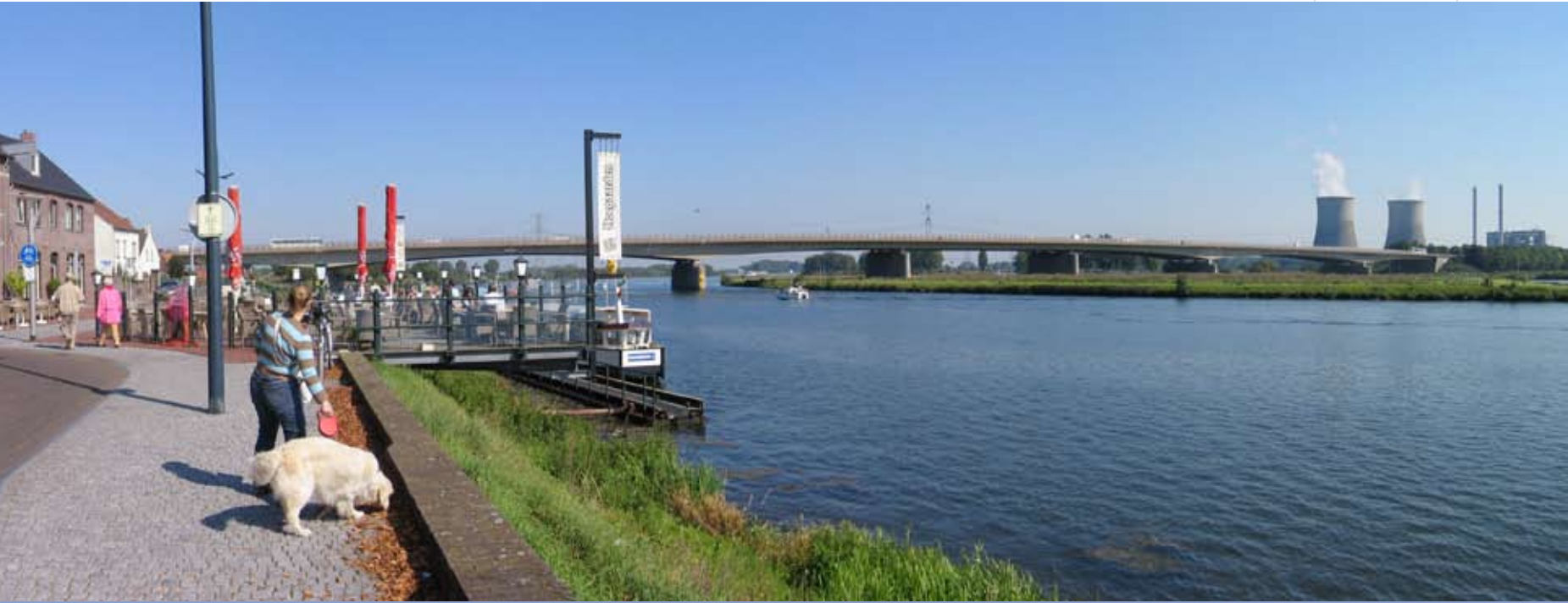
Foto 7.11 - Maasboulevard Wessem met uitzicht op A2-brug en Clauscentrale
