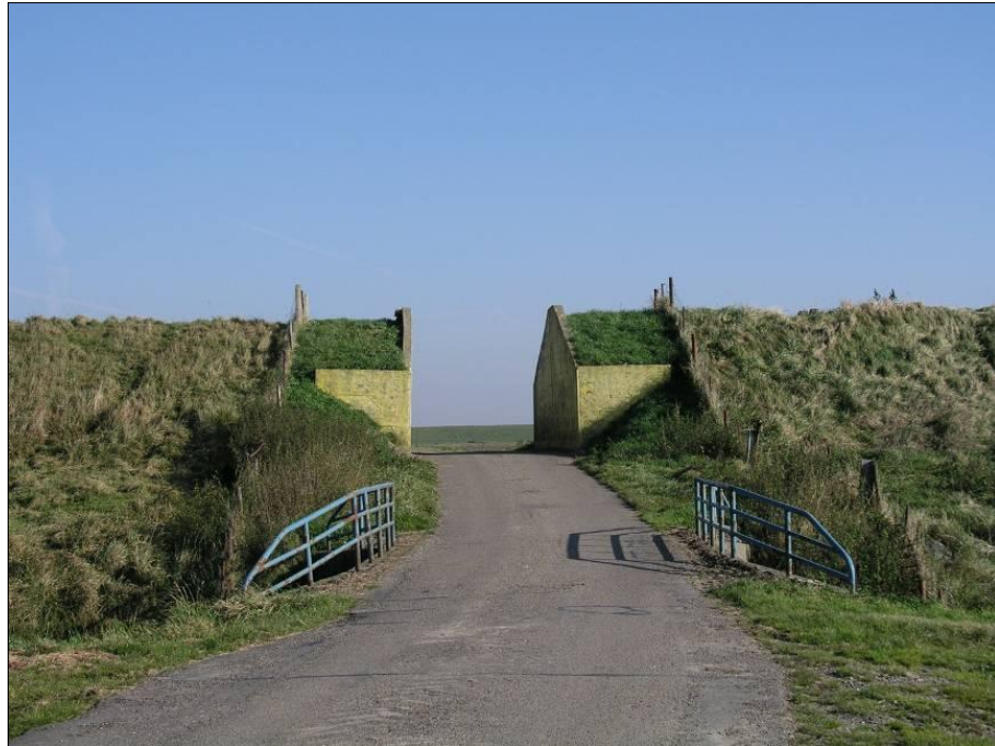
Dijkcoupure in de Polderdijk
