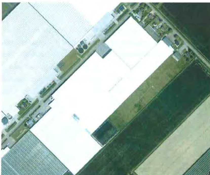
Huidige situatie luchtfoto
