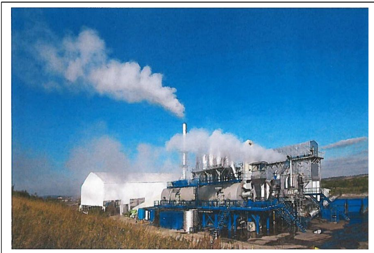
Foto 2: thermische reinigingsinstallatie locatie Chesterfield (UK)
