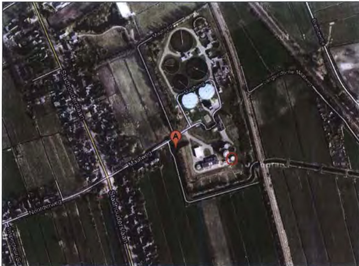
Figuur 9: Biogas opslag bij de RWZI Soest (Rode cirkel)
