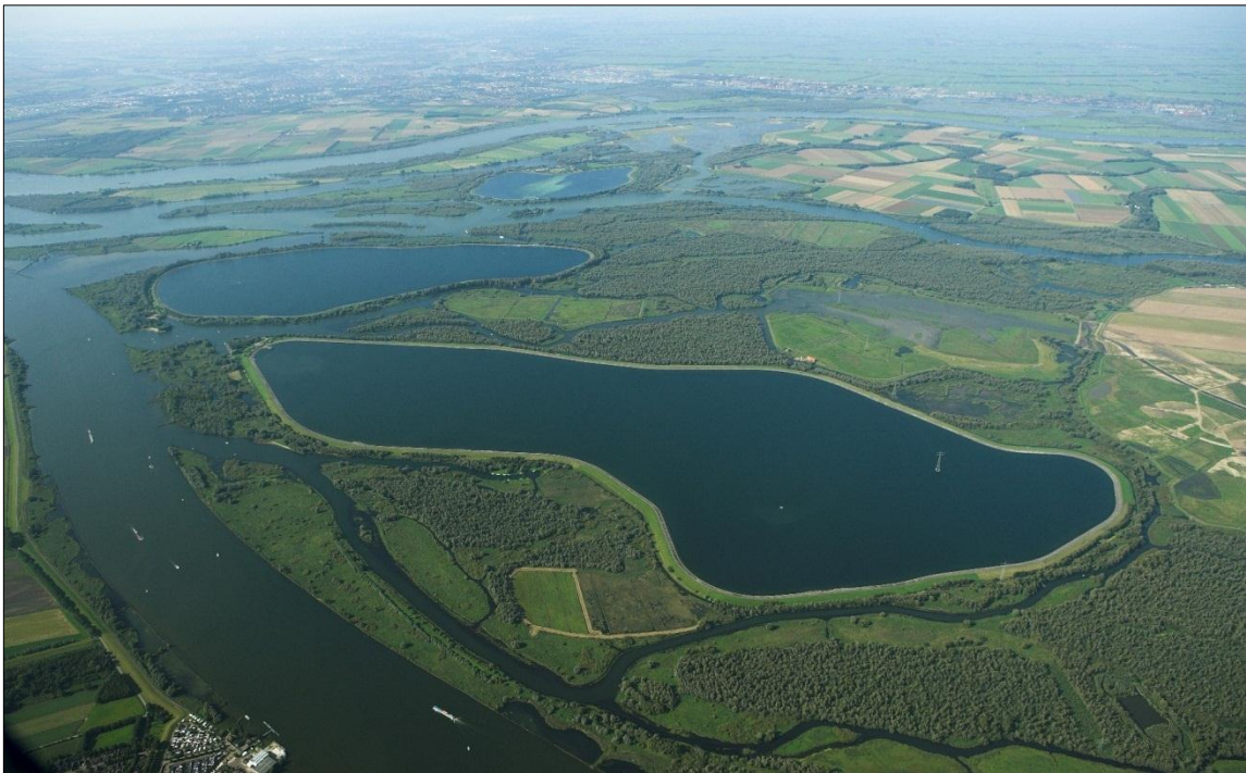
Afb. 2 Luchtfoto spaarbekkens Evides in de Brabantse Biesbosch (bron: Evides)
