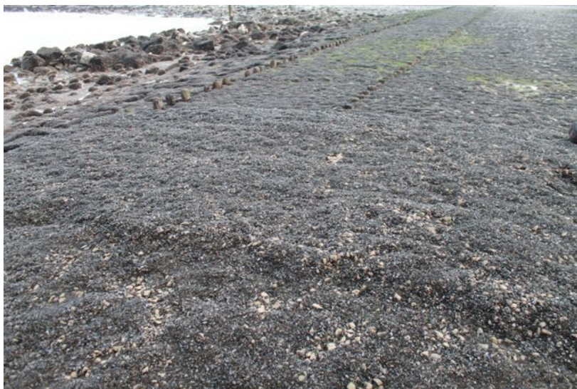
Foto 1 Strandhoofd met Elastocoast. Op de voorgrond is een deel te zien met, op de achtergrond zonder Elastocoast.
