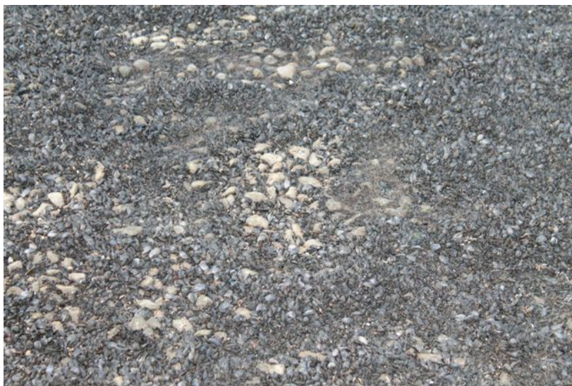
Foto 2 Detail van met Elastocoast behandeld strandhoofd.
