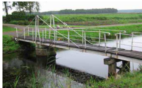
Figuur 26. Brug over het kanaal langs de Tripscompagnieweg
