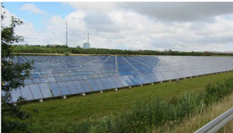
Figuur 33. Zonnepanelen in de wei (Duitsland)
