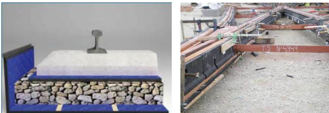
Afbeelding 19 Links: trillingsreductie met isolatiematten, rechts: trillingsreductie door isolatie rond de spoorstaaf
