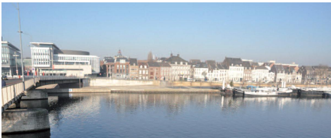
Afbeelding 30 De Maasboulevard met de vork van de Wilhelminabrug en kademuur
