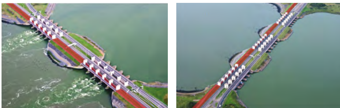
Afbeelding 4.1 Luchtfoto's met in rood de waterkering van de spuicomplexen Den Oever (rechts) en Kornwerderzand (links) (links: Waddenzee)
