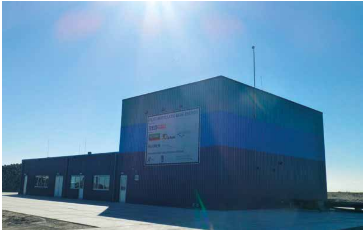
Pilotinstallatie Blue Energy (bron: Redstack)
