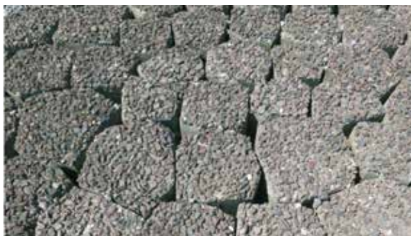
Gezette betonzuilen met afstrooilaa
