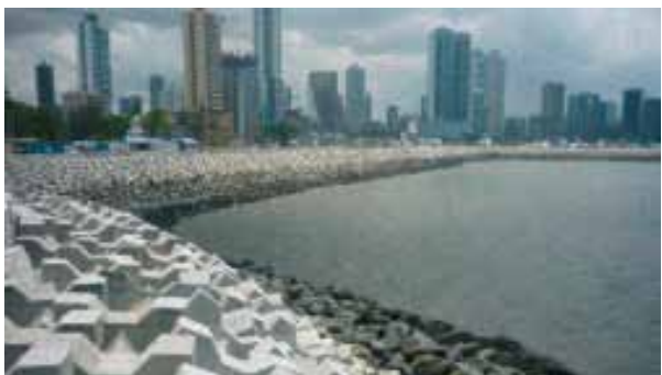
X-blokken alleen indien regelmatig gelegd
