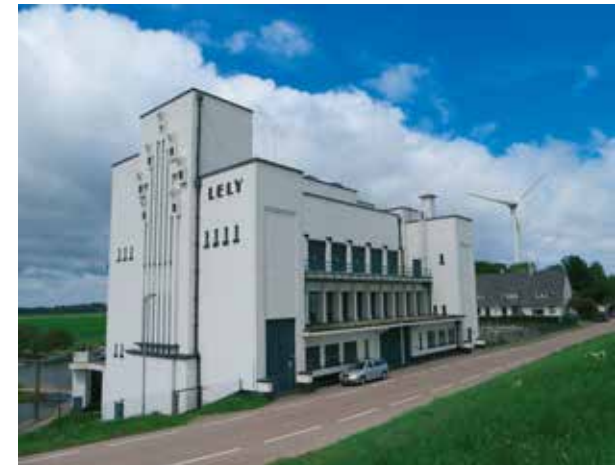
Gemaal in de Wieringermeerpolder bij Medemblik: gelijkenis met architectuur heftorens
