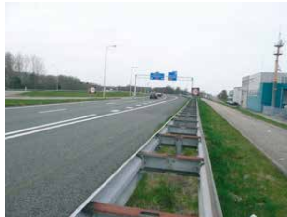
Den Oever: knooppunt van weg- en waterwegen
