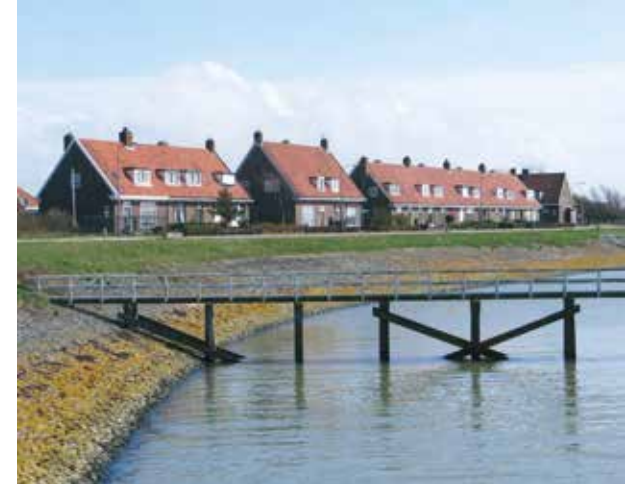
Sluiswachterswoningen, na 1945 herbouwd
