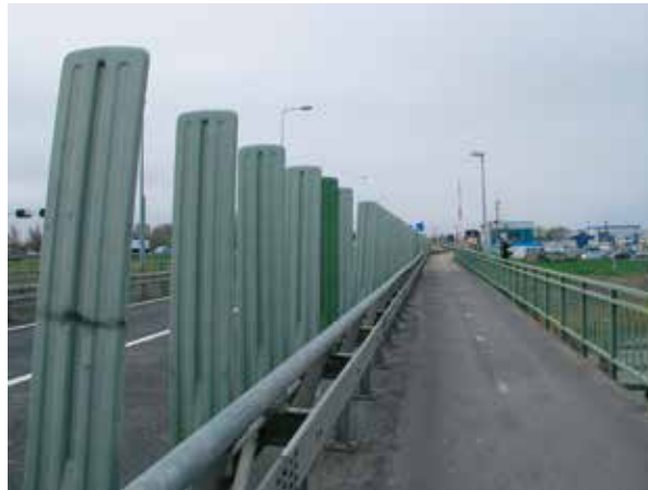
Fietspad op draaibrug
