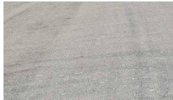
Asfalt- alleen op horizontaal vlak berm mogelijk
