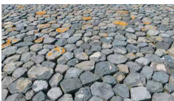
Herstel basaltbekleding in voorhavens en bij aansluiting kunstwerken
