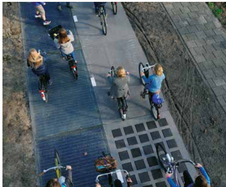
Proefvak SolaRoad Krommenie
