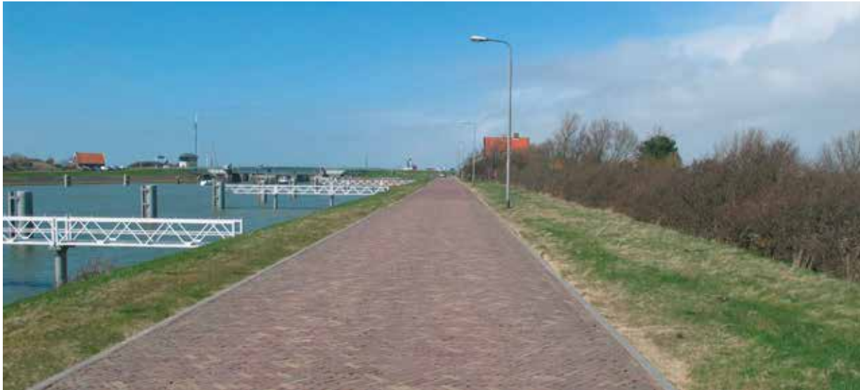
Waterkering rond voorhaven op + 5 meter NAP
