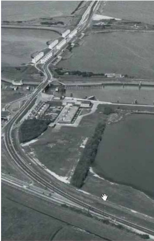
Den Oever omstreeks 1960: aanplemping in de Zuiderhaven
