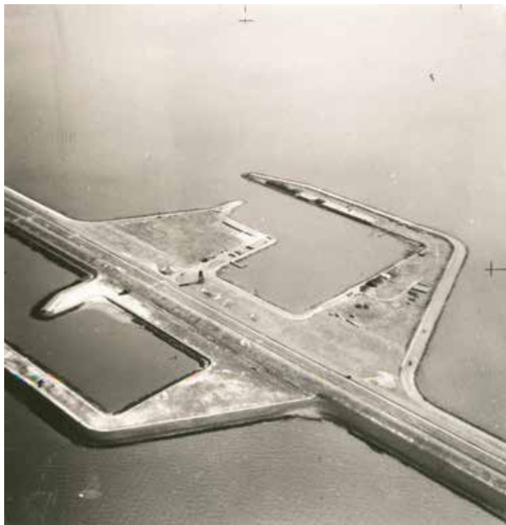
Breezanddijk omstreeks 1965: strakke vorm voormalig werkeiland
