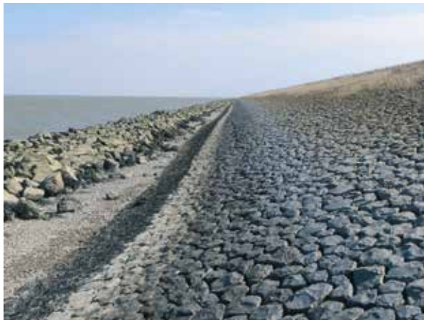
Basaltbekleding Afsluitdijk: fijnkorrelige textuur, verlopende kleuring van teen tot kruin
