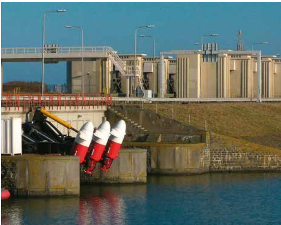
Beeld van de zojuist geïnstalleerde proefopstelling voor stromingsenergie bij Den Oever (bron: Tocardo)
