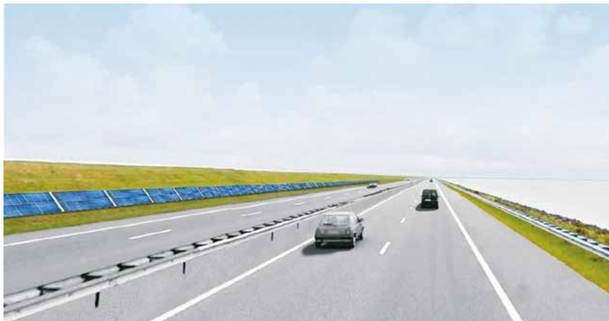
Twee rijen zonnepanelen laag op het talud
