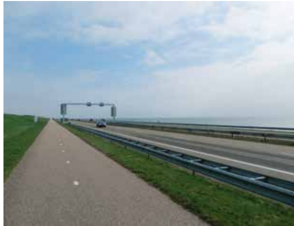
Fietspad tussen dijktaled en autoweg
