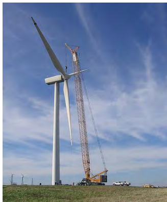
Figuur 4.6 Voorbeeld van een kraanopstelplaats nabij een turbine
