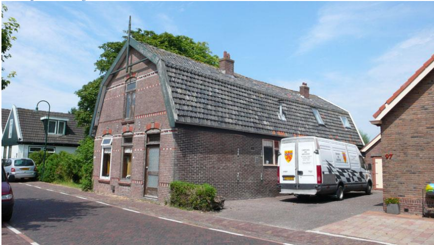
Foto 14, Een mansardekap in Schermer in de juiste maatverhoudingen
