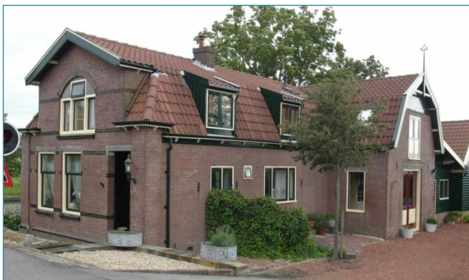
Foto 15, zorgvuldige detaillering van dakkapellen passend bij de mansardekap (foto bij de Oterlekerweg in de Schermer)
