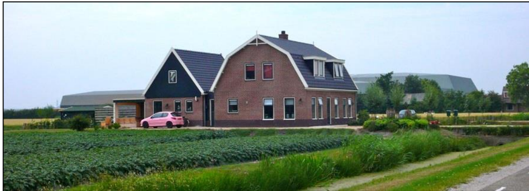
Foto 13, Eén uitzondering is recent gerealiseerd. Deze woning (Molenweg 8 Ursem) wijkt op een aantal punten af van zijn voorgangers: het bouwdeel met mansardekap is breder dan de historische voorbeelden, er staat een bouwdeel tegenaan met zadeldak (wat een voor het gebied wezensvreemde ingreep is om toch een groot volume te realiseren) en in de mansardekap zijn aan de wegzijde twee grote dakkapellen aangebracht.
