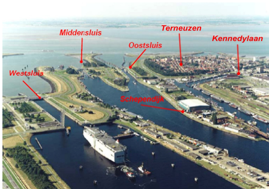
Figuur 2.3 Overzicht Sluizencomplex Terneuzen
