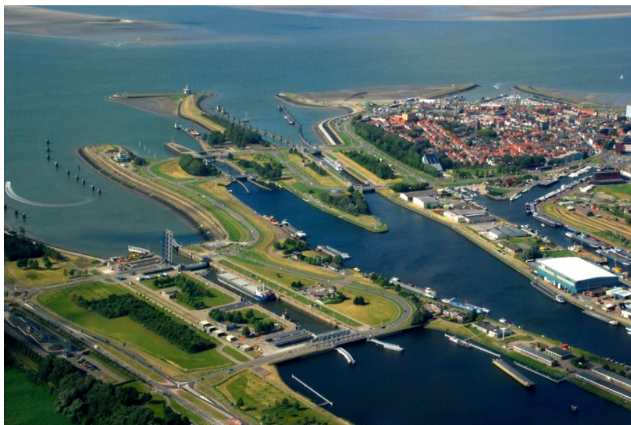
Figuur 2.3 overzicht sluizencomplex Terneuzen met Terneuzen op de achtergrond
