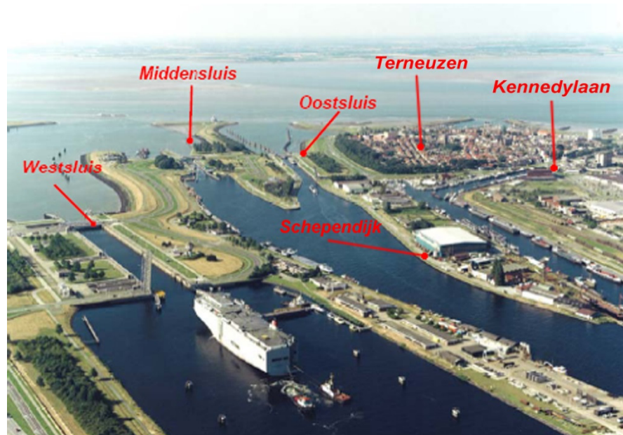
Figuur 2.2 Overzicht Sluisencomplex Terneuzen
