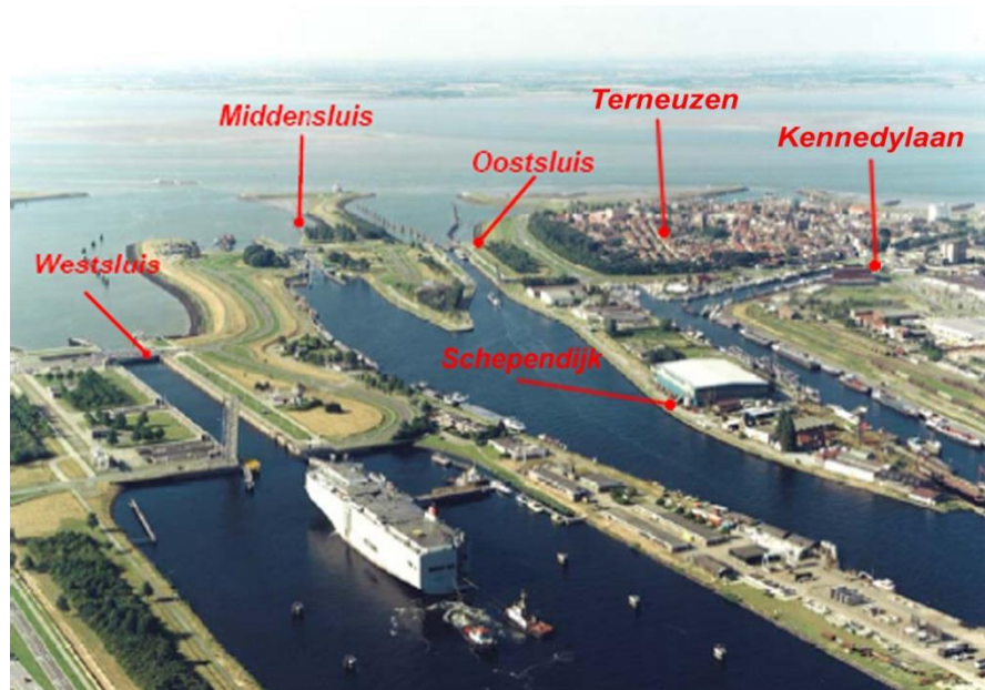
Figuur 2-2 Overzicht Sluisencomplex Terneuzen
