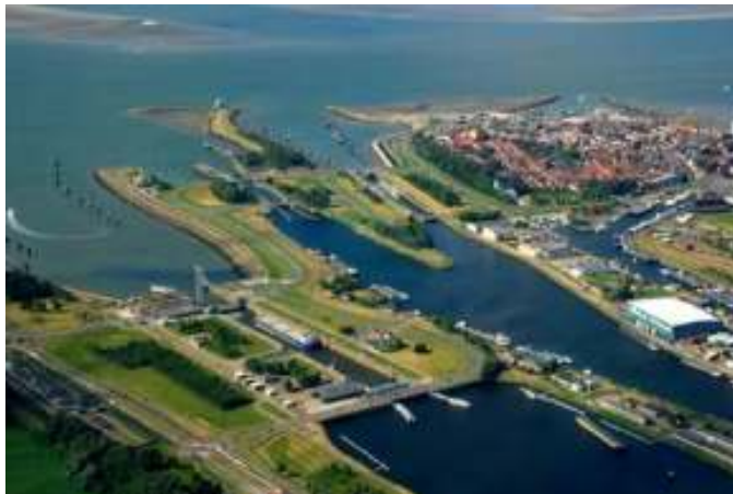
Figuur 1.2: Overzicht sluizencomplex Terneuzen met Terneuzen op de achtergrond.
