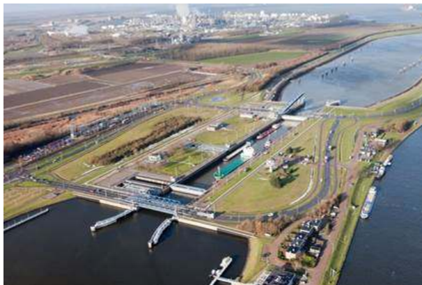
Figuur 1.1: Westsluis van het sluizencomplex Terneuzen (bron: Rijkswaterstaat, Joop van Houdt).
