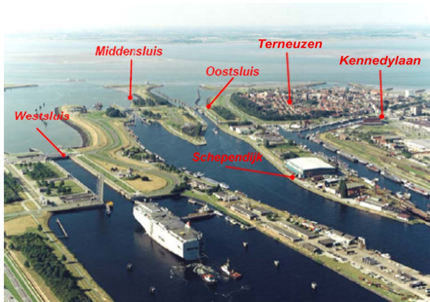
Figuur 2-2 Overzicht sluizencomplex Terneuzen
