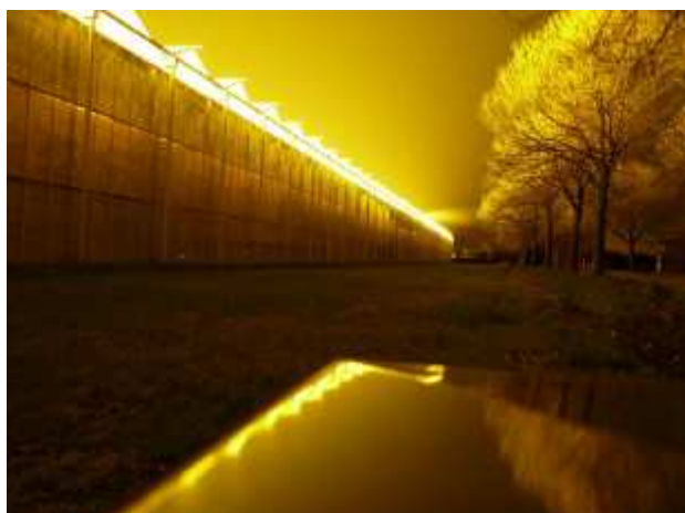
lichtemissie uit kas zonder bovenafscherming
