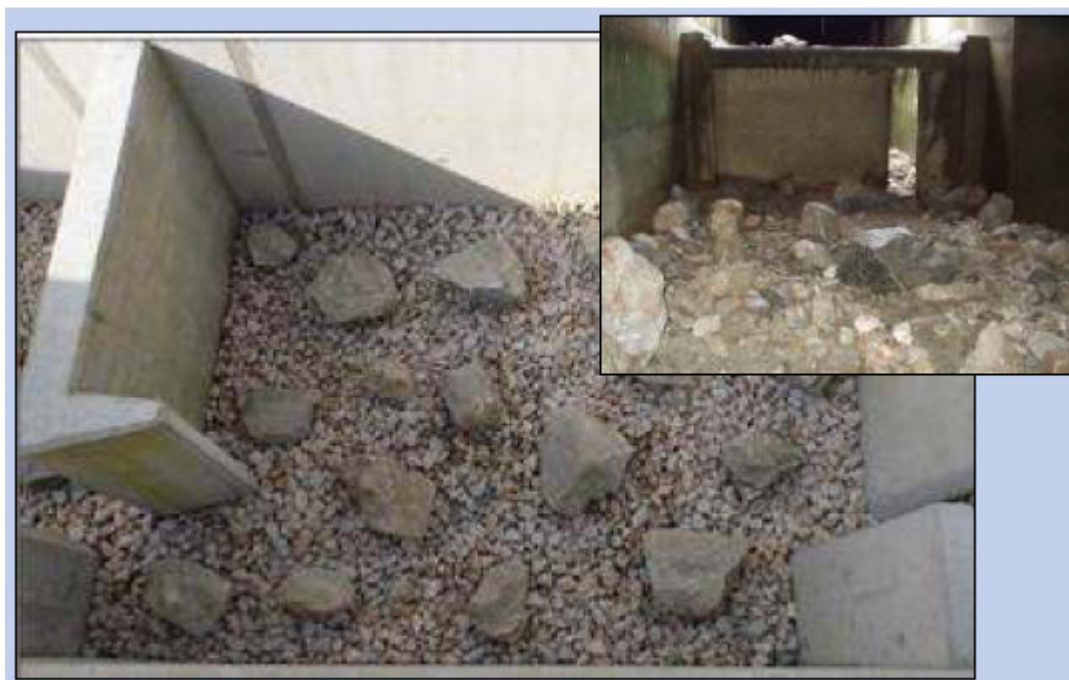
Figuur 12. Stenen bodembedekking in een vertical slot vispassage.
