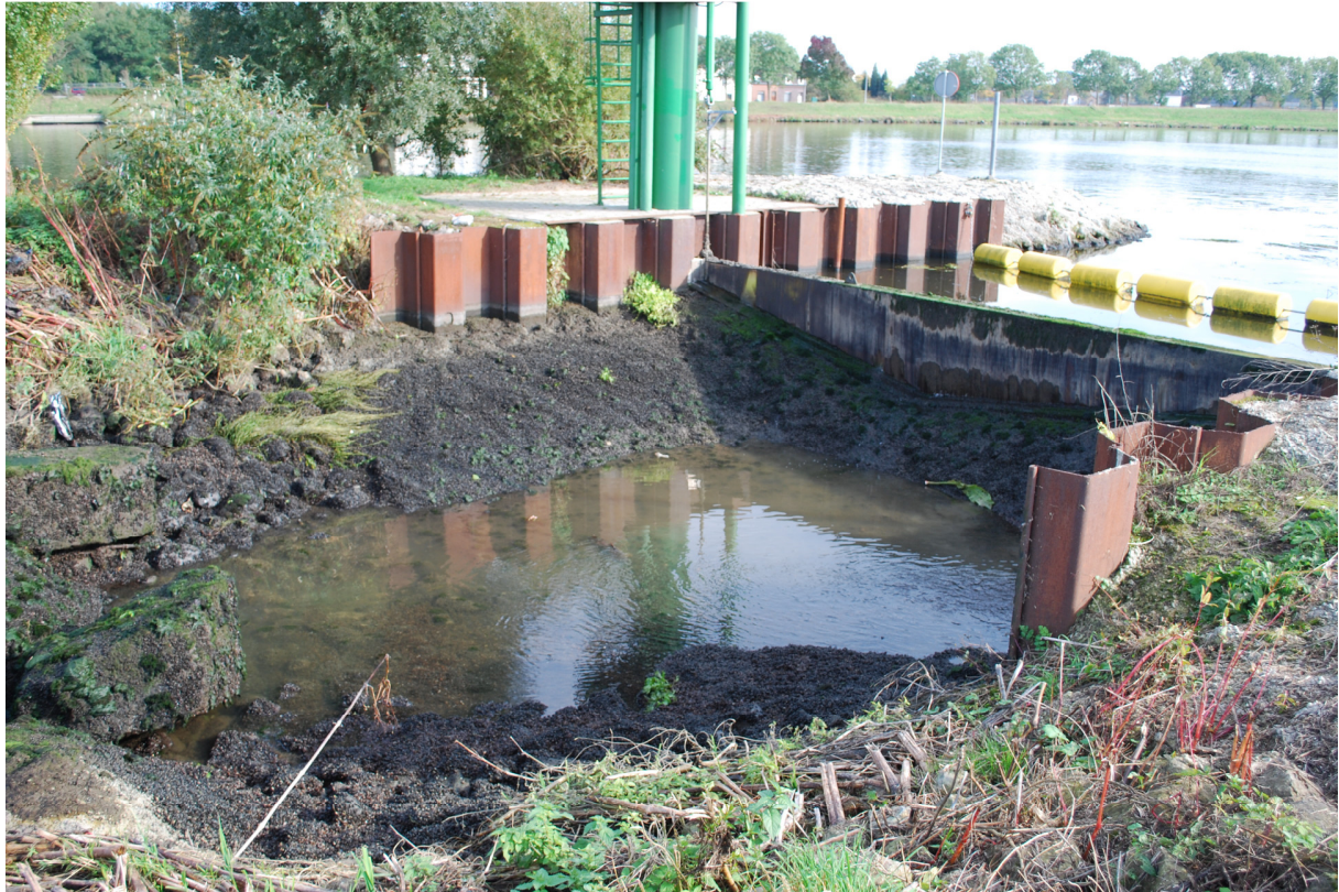
Afsluiter van vispassage Borgharen op de Maas (in gesloten toestand, droog staande vistrap)
