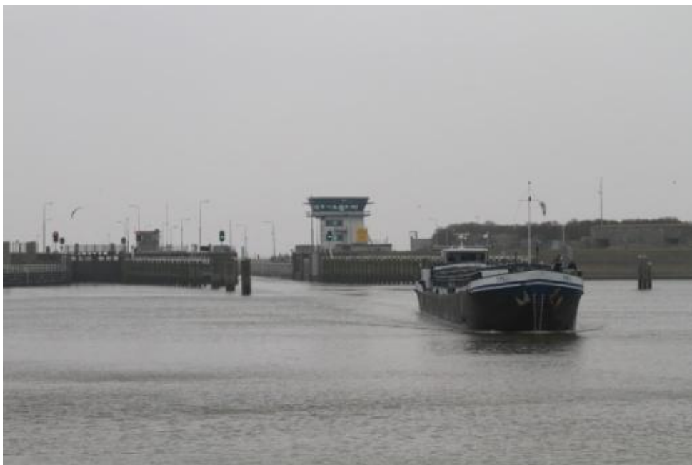
Figuur 10. Schutsluizen Kornwerderzand (Lorentzsluizen).
