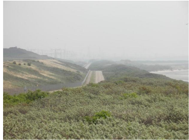
Figuur 2.9: SL9 Slufterdam Buitentalud
