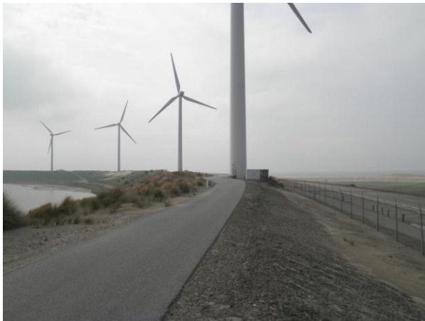
Figuur 2.11: SL12A Slufterdam Binnentalud
