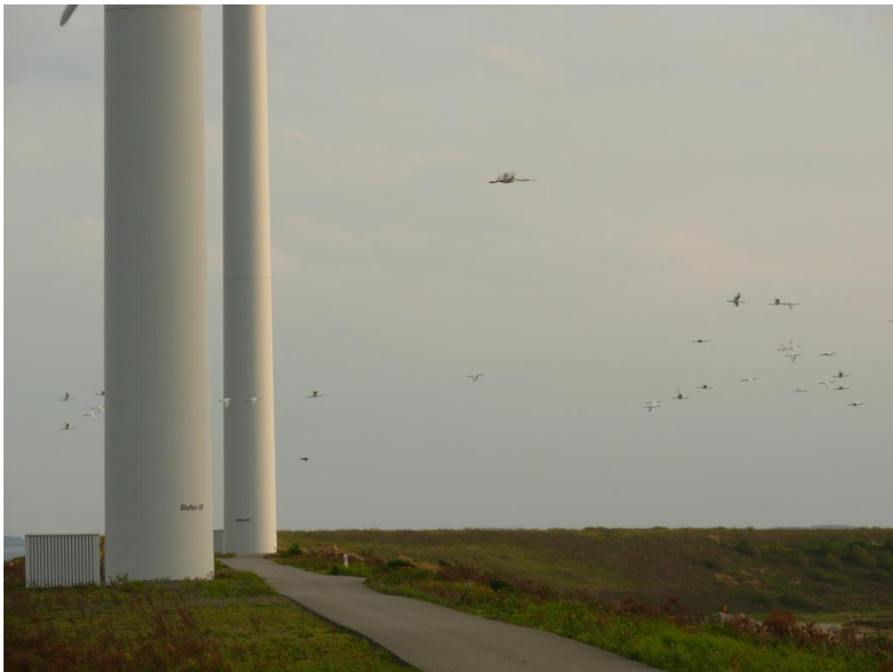
Foto 5.2 Een groep lepelaars vliegt vanuit het kleizettingsgebied de Slufter in en passeert de oostelijke Slufterdam tussen turbine 1 en 2 op een hoogte van circa 15 m boven de dijk, 10 september 2012 (foto: Hein Prinsen).
