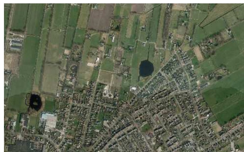
Heidedorp Harkema, huidige situatie: verspreide, willekeurig geordende bebouwing (Luchtfoto 2012)
