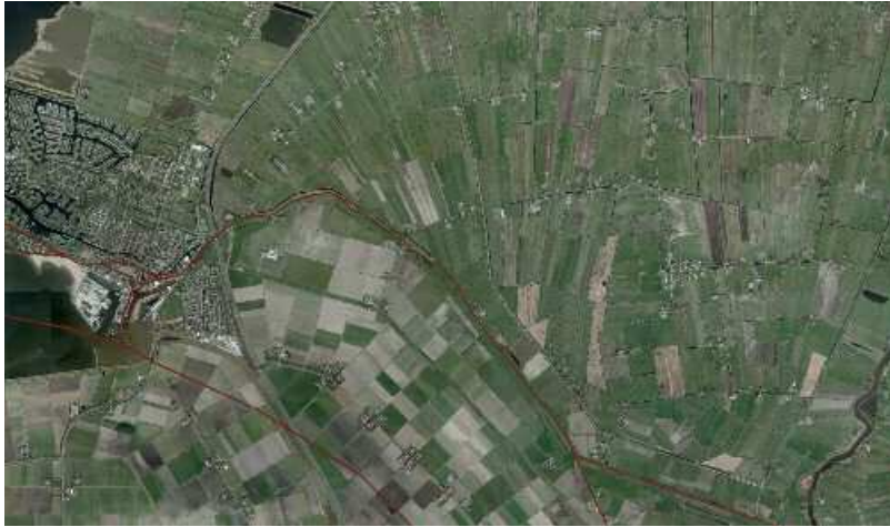
Zuiderzeedijken (Luchtfoto + CHK2)
