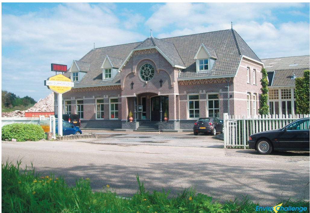
Illustratie 2 : Zicht op kantoorgebouw vanaf Heeswijkseweg anno 2014
