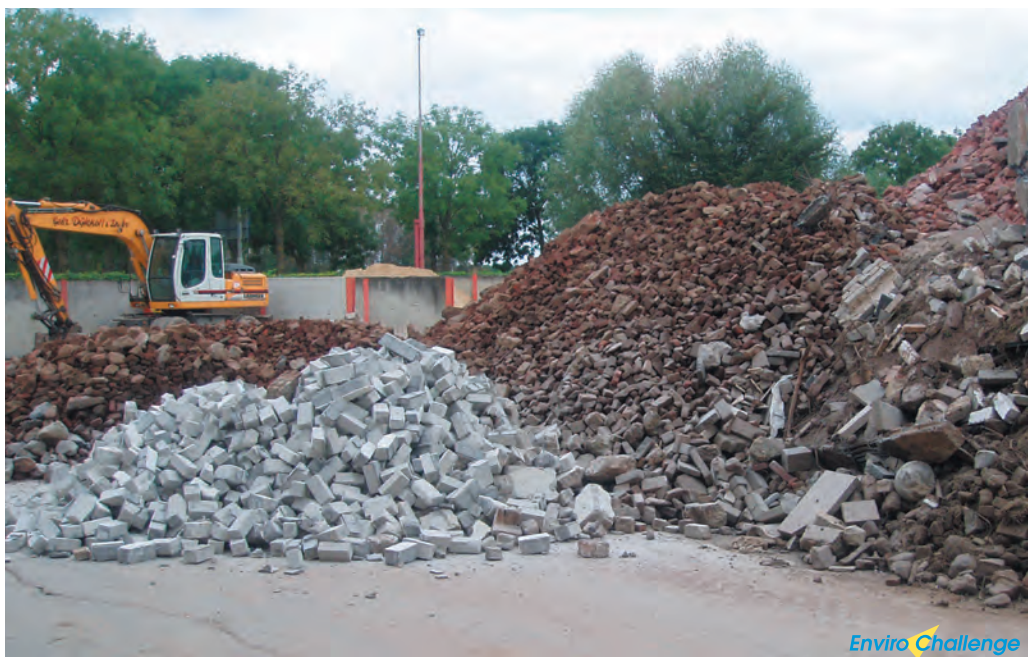
Illustratie 6 : Opslag van steenachtig bouw- en slooppafval (puin) op vloeistofkerende vloer
