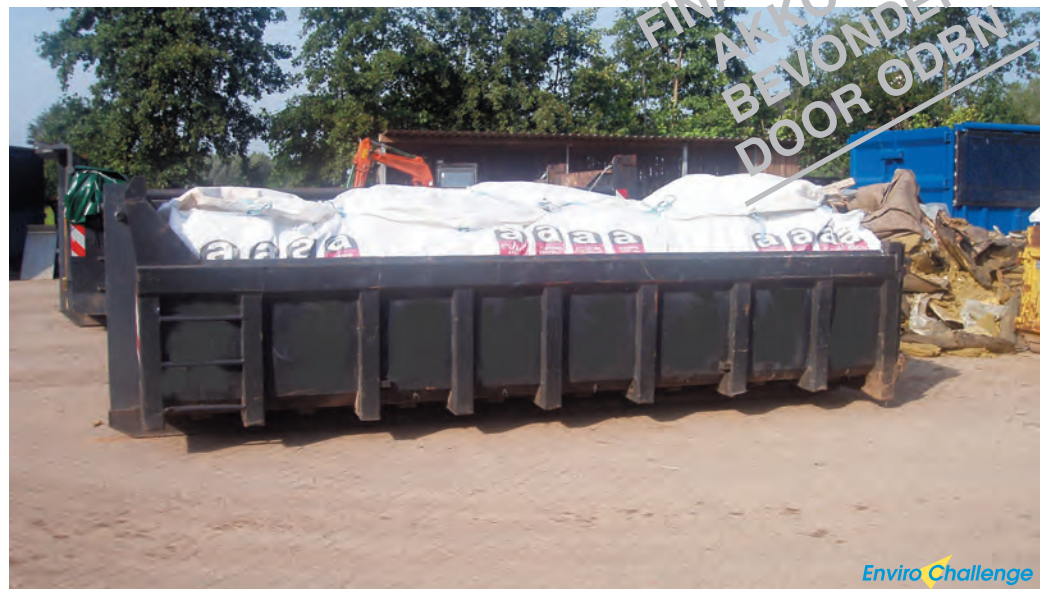
Illustratie 2 : Opslag asbesthoudende materialen op vloeistofkerende vloer
