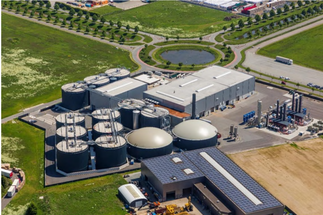
Figuur 1: Bestaande situatie vergistingsinstallatie BEC (bron: NRD).
