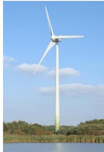
Figuur 10: de turbines van het project Kilwind zijn van het type Enercon E70, masthoogte 85 m. Referentie hiervoor is De Amstelvogel in Oudekerk aan de Amstel, alleen dan zonder het groene verloop aan de onderkant van de mast
