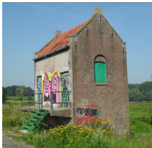
Oude gemaal aan Defensiedijk
