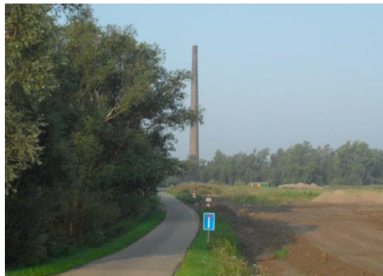
Schoorsteen vm. steenfabriek
