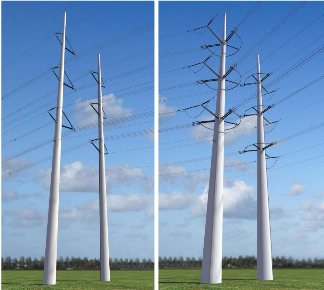
Figuur 2.3 Steun- en hoekmasten 380/150-combi
