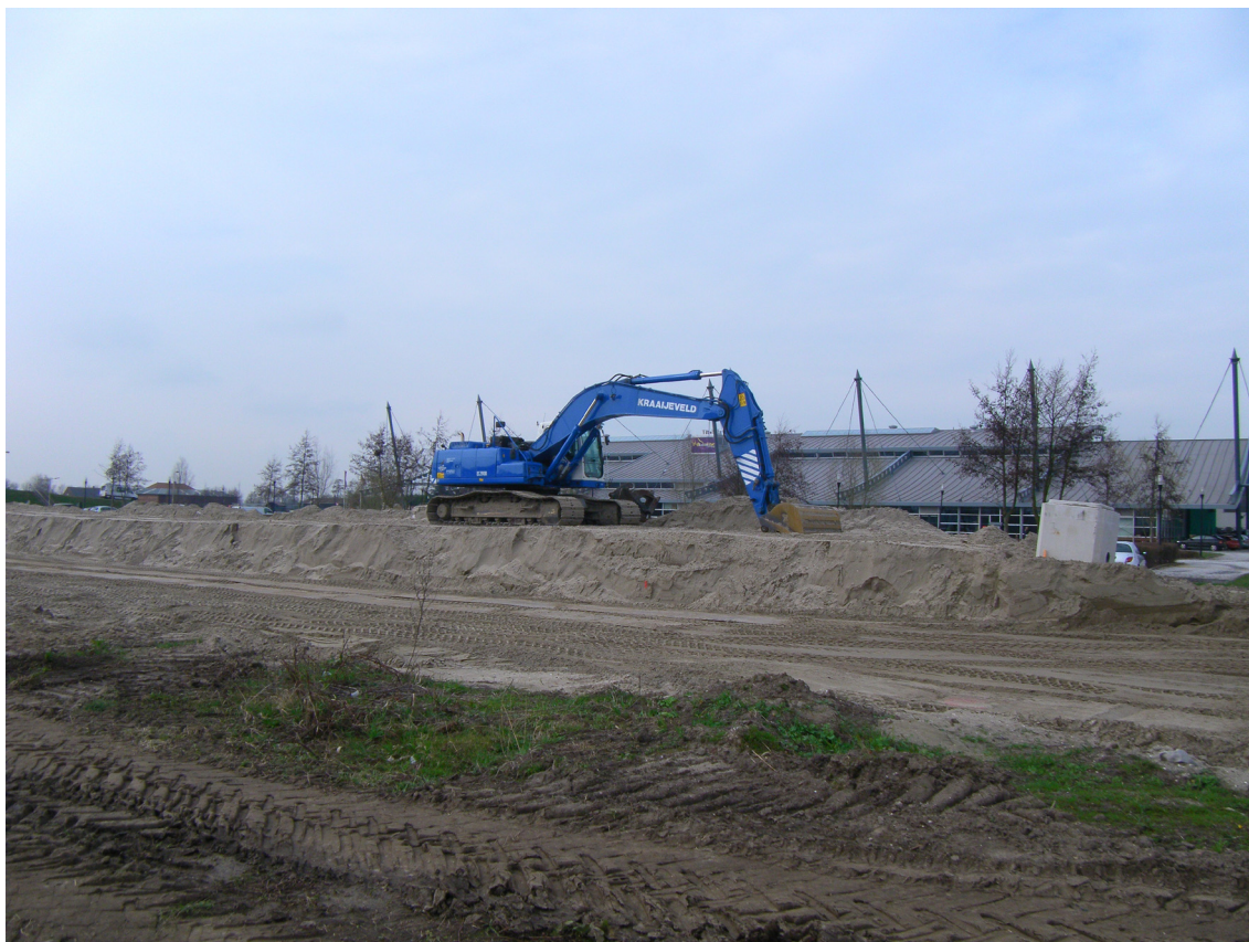
Figuur 11. Foto genomen vanuit het zuiden met de huidige situatie (winter 2010) direct ten oosten van de Molenburgsewag en ten noorden van de Betuwe-route in het plangebied.
