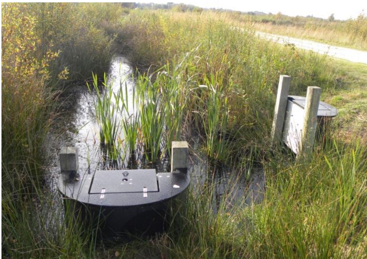
Figuur 6. KWS stuwen in het Bargerveen.
