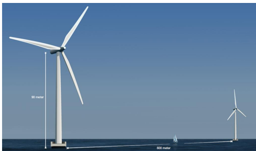
Figuur 5.6 Impressie onderlinge afstand windturbines 600 meter
