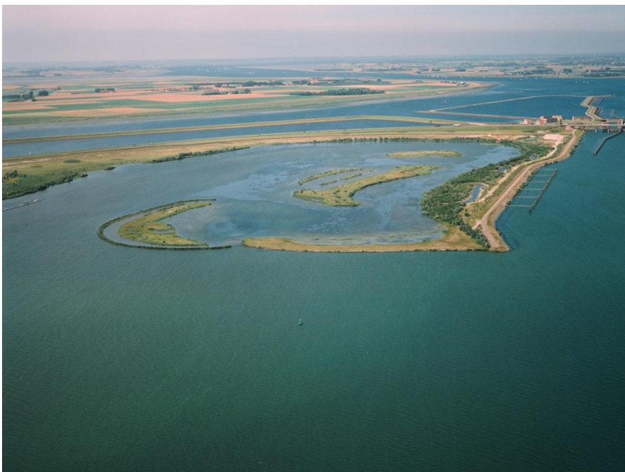
Figuur A.2: Krammerplaat, rechts Krammersluizen (foto RWS).
