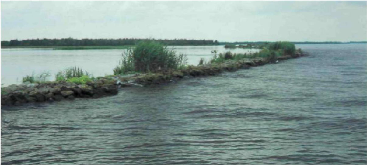
Figuur A.5b: Vooroeververdediging tegen golfwerking (RWS-RIZA 1998).
