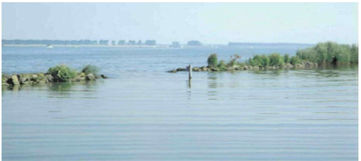
Figuur A.5a: Vooroeververdediging met doorlaatopening, RWS-RIZA, 1998.
